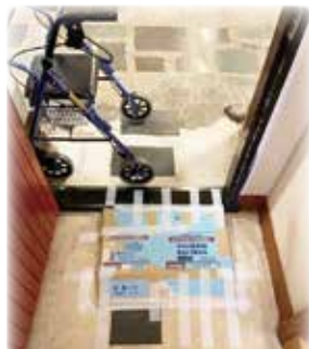
段ボールなど使用した 簡易スロープの 設置・段差解消
