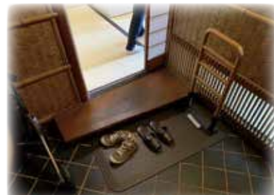
段差へ手すりの設置
